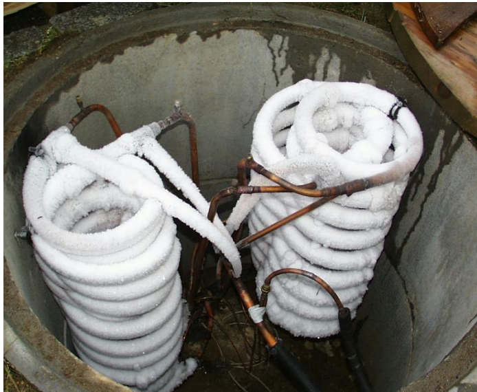
U-Rohr-Verdampfer mit Ölfallen
