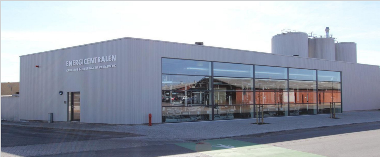
Fig 2: Bjerringbro Varmeværk in Bjerringbro [www.bjerringbro-varme.dk].
